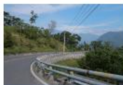
斜坡轉彎道路
